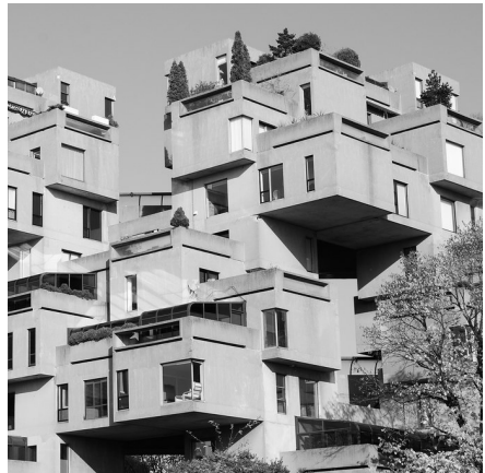
- Habita 67 Moshe Safdie Montreal, Kanada - 1967
